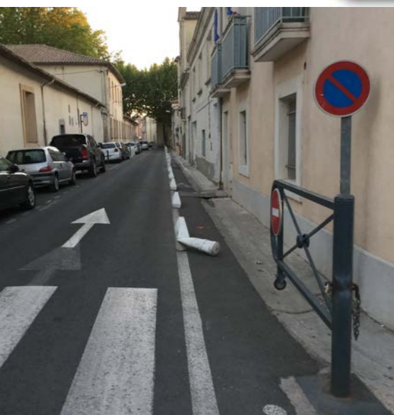
Les piétons de la rue Lakanal marchent dans un caniveau...
